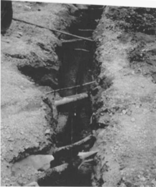
**Bild C.1:** Einbau einer Druck- bzw. Unterdruckleitung unter querenden Versorgungsleitungen
