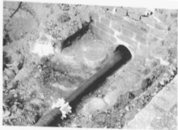
**Bild C.3:** Einzug einer Druck- bzw. Unterdruckleitung mit Abstandshalter in einen bestehenden Kanal
