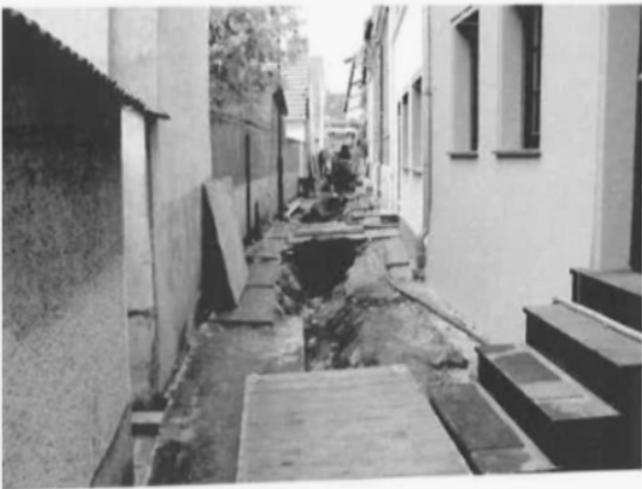
**Bild C.2:** Verlegung einer Druck- bzw. Unterdruckleitung in einem dicht bebauten, innerstädtischen Bereich
