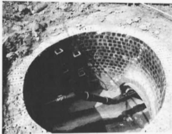
**Bild C.4:** Nutzung eines bestehenden Schachts zum Einbau eines Höhengsprungs (UES)
